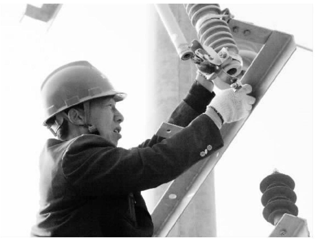
商水县电业局利用近日天气晴好的有利时机,加紧对变电设备、供电线路进行检修改造,确保冬季负荷高峰期间群众安全可靠用电。图为该局员工正在谭庄镇三义台区改造电网。(杜放光 赵丽娜 摄)
