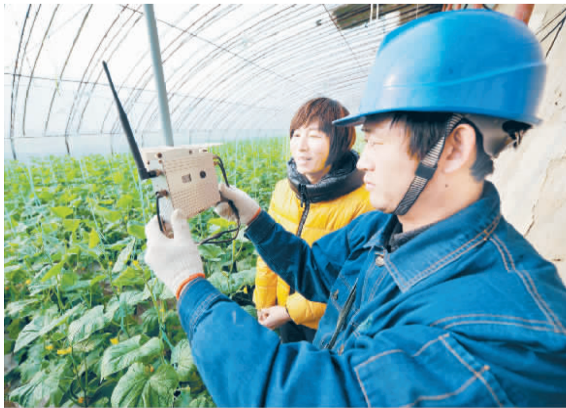
图为山东潍坊寿光供电公司工作人员为现代化蔬菜大棚安装远程监控设备。近年来，山东寿光不断加大大棚蔬菜种植的科技投入，对大棚蔬菜实施温度、湿度等科学化种植管理。为确保大棚蔬菜种植冬季用电，国家电网寿光供电公司投资 2 亿多元对全市农村电网进行改造，为大棚蔬菜生产提供充足、可靠的电力供应，确保大棚蔬菜种植高科技设备汽肥机、温控仪、臭氧杀菌仪等应用到蔬菜生产中，农民种菜变得省时、省力。目前，寿光蔬菜大棚种植面积达 80 万亩，年产各类蔬菜超过 40 亿公斤，销往全国各地。(新华社记者 范长国 摄)
