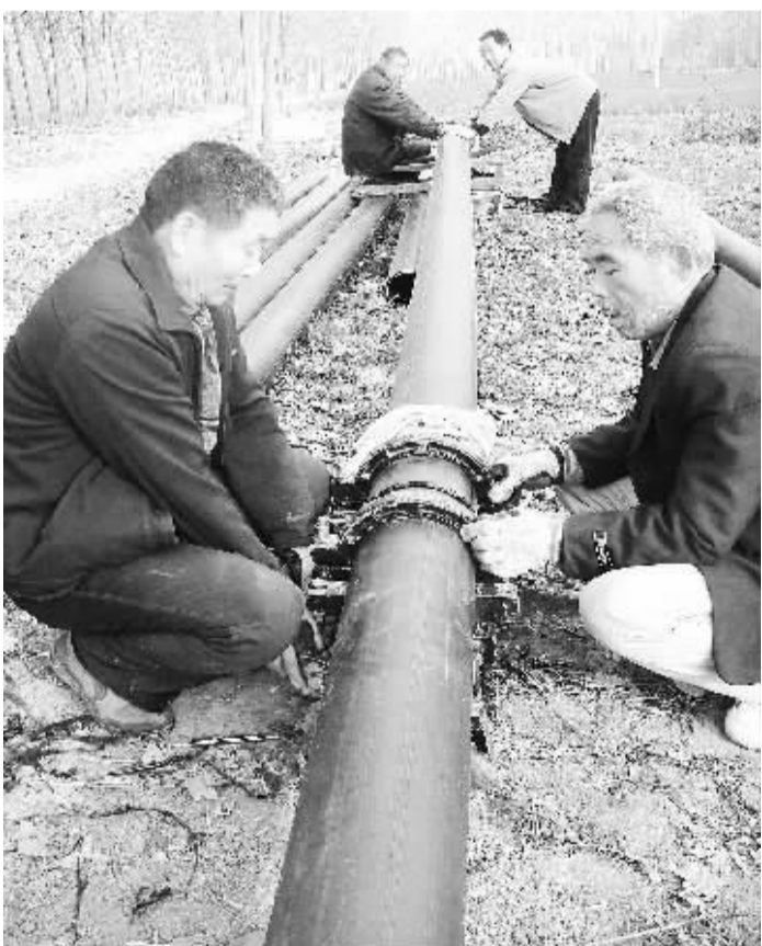
连日来,商水县平店乡十大民生工程之一的安全饮水项目正在紧张施工。自2008年开始实施安全饮水项目以来,总投资已达1800多万元,铺设管网3万多米,已解决3.3万人的安全饮水问题。(赵永昌 摄)
