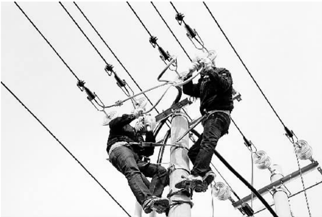
图为项城市电业局的工作人员正在检修线路。进入冬季以来,该市用电负荷加大,为了保障企业和市民用电,该局24小时轮流值班,全天候保障用电。(赵献伟 朱培波 摄)
