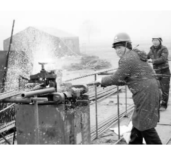
项城港是项城市十五项重点基础设施项目之一，总投资2亿元，设计码头靠泊能力500吨级、水工结构兼顺1000吨级、泊位数8个，年吞吐能力350万吨/年。图为港口内工人正在施工。（朱亚洲 摄）
