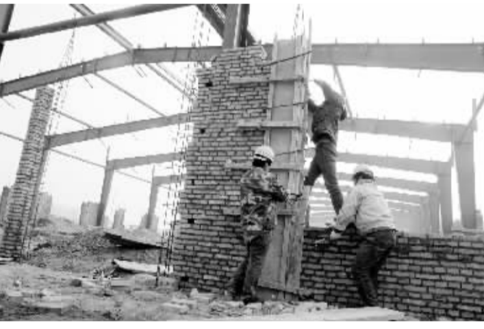
位于产业集聚区的迈特新能源项目正在加快建设。新春伊始,县各有关部门狠抓招商项目建设关键环节,加快招商引资项目建设进度,全力在招商项目建设上取得新突破。(韦伟 迟驰 摄)
