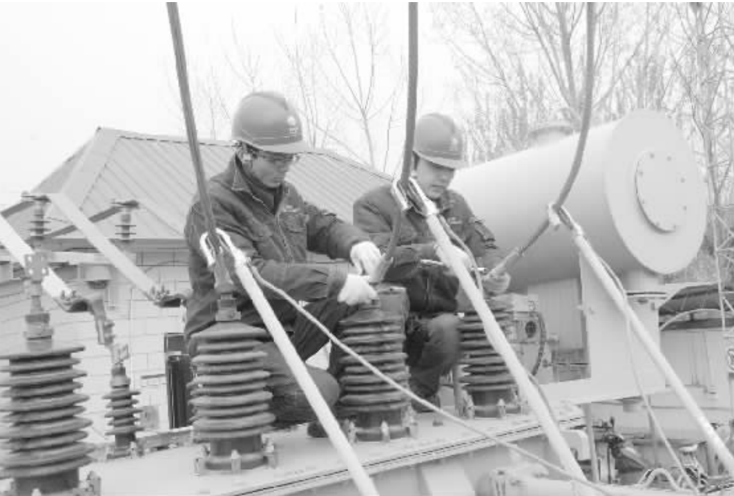
扶沟县供电公司早预案、细安排、抓规范、促落实,有序开展2013年春季预防性试验,进一步提升设备健康水平,确保供电可靠,为电网迎峰度夏提供坚强保障。图为3月26日,该公司检修人员在35kV韭园变电站对2号主变进行预试。(刘滨 刘军胜 摄)
