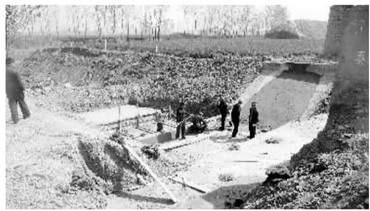
在赵德营镇麦田间工人们正在维修一个提灌闸。
