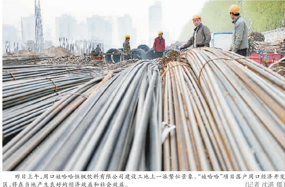
昨日上午,周口娃哈哈恒枫饮料有限公司建设工地上一派繁忙景象。“娃哈哈”项目落户周口经济开发区,将在当地产生良好的经济效益和社会效益。(记者 沈湛 摄)
