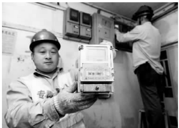
北京全面启动换装智能电表工作 5月9日,在北京一居民小区的换装现场,工作人员在展示即将安装的智能电表。当日,北京市智能电表换装工作全面启动。智能电表作为新一代电能表,除了具备电能计量的基本功能外,还具有用电信息存储、远程采集、信息交互等功能。与原有的卡式表和机械式表相比,智能电表在购电方式、电量电费查询、优化用电习惯等方面具有明显优势。 新华社记者 公磊 摄
