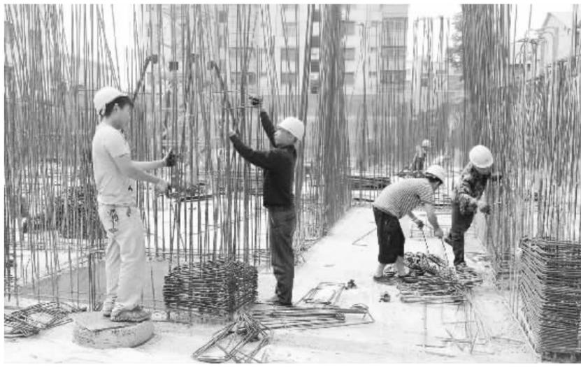
5月23日上午,在界牌街棚户区改造项目交通路金泽园安置区建设工地上,工人们正忙着绑扎钢筋。据项目负责人介绍,该项目从2012年开工建设,将于明年年底竣工,建成后安置界牌街拆迁户近200户,700余人。(樊葩蕊 李磊 摄)
