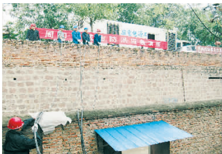
雨季即将到来。5月31日上午,城市管理局市政管理处举行防汛应急演练,模拟突发事件下市内各泵站如何快速恢复排水工作。图为模拟紧急停电状态下,工作人员启动应急电源车、连接电缆恢复泵站供电。(王亚辉摄)
