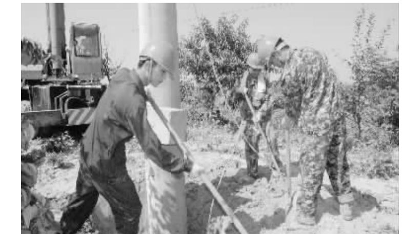
8月7日,扶沟县电业局员工冒着高温紧张施工,架设5.5千米35千伏崔五线,此线路的建成,可将廉岗、常营两座110千伏变电站进行联网,实现线路经济、可靠运行。 (记者 王泉林 通讯员 刘滨 刘军胜 摄)
