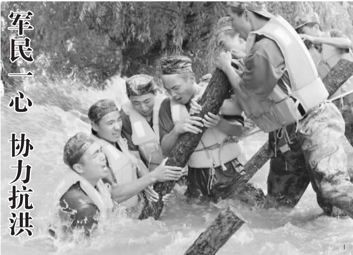
图1:驻黑部队近两万兵力奋战三江抗洪一线 沈阳军区16集团军某装甲团官兵在大庆市肇源县莲花乡洼子屯段打桩加固高松花江大堤(8月19日)。连日来,驻黑部队连续出动兵力奔赴三江流域抗洪抢险,截至目前已有近两万名解放军和武警官兵、民兵预备役人员奋战抗洪一线,增配的储备冲锋舟、橡皮舟、救生衣、救生圈、植桩机等三万余件抗洪物资也运达灾区。 本栏文图均为新华社发
