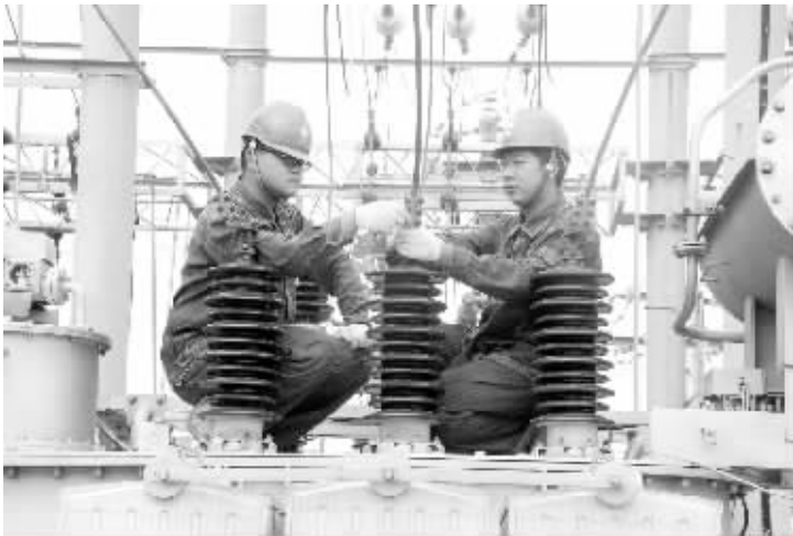
连日来，扶沟县电业局组织员工开展秋季安全大检查活动，对查出的各类缺陷、隐患进行彻底整改消除，确保电网安全稳定运行。图为 9 月 12 日该局员工在曹里 35KV 变电站更换主变设备线夹。（刘滨 袁红梅 摄）
