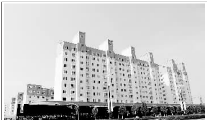
旧城改造是最大的民生、发展的平台、城市的形象。今年,川汇区先后启动了19个旧城改造项目,计划征收面积160万平方米,目前已完成38.2万平方米,建设安置房1679套。图为在建的文昌大道综合改造工程安置B区安置房。(理效明 樊艳蕊 摄)
