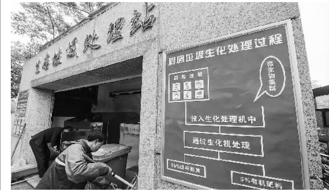
社区建起生态垃圾处理站 厨房垃圾“变身”生态肥料 11 月 14 日,工作人员拿出经过降解处理后的生态肥料。从 11 月初开始,杭州市西湖区西溪街道溪畔社区正式启用社区生态垃圾处理系统,这也是西湖区首个启用的社区生态垃圾处理系统。社区对各家各户普及垃圾分类知识并免费发放实名制垃圾袋;然后将居民产生的厨房垃圾进行分拣,利用生态垃圾处理设备进行降解处理。正式投入运行的有机垃圾生化处理机 24 小时运行,每天可以处理厨房垃圾 200 公斤,通过微生物发酵分解,大部分转化为无害气体和水,剩下的变成生态肥料,免费提供给种植花木的小区业主。
