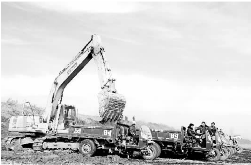
12月12日,商水县尚岗乡境内颍颥河通航枢纽工程大路李段正式开工建设。据悉,该工程投资3亿多元,枢纽按泄水闸泄洪规模确定为II等工程,泄水闸设计洪水流量为3000立方米/秒,大路李船闸为IV级船闸,船闸建设规模为500吨。(吕耀光 摄)
