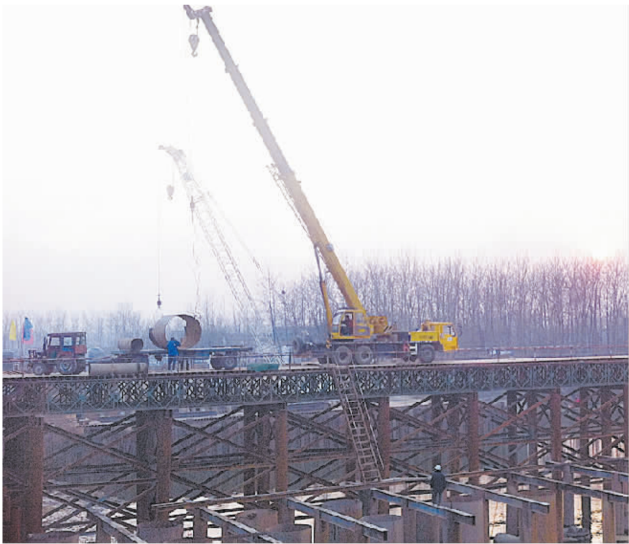
新年伊始,我市重点项目建设紧张进行。图为中心城区最大桥梁——东环路八车道沙河河跨河大桥正在紧张建设中。(记者 刘彦章 摄)
