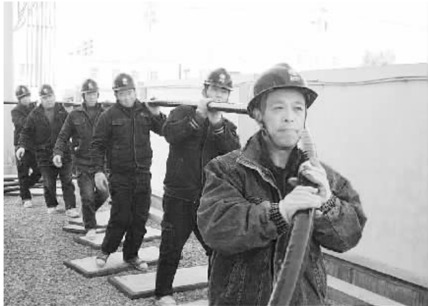
为确保迎峰度冬期间用户用电无忧,郸城县电业局加快线路施工进度,积极迎战冬季大负荷。图为郸城县电业局修试工区城郊二所施工人员进行 110 千伏赵寨变电站超 8 线路敷设电缆。
