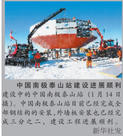
中国南极泰山站建设进展顺利 建设中的中国南极泰山站(1月14日摄)。中国南极泰山站目前已经完成全部钢结构的安装,外墙板安装也已经完成三分之二,建设工程进展顺利。 新华社发
