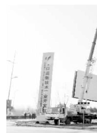
图为城管局工作人员利用吊车拆除违章建造的广告牌。(记者 王亚辉 摄)
