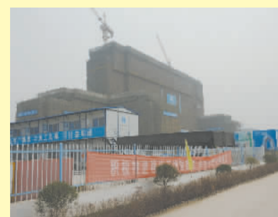
正在建设中的政府综合大楼。
