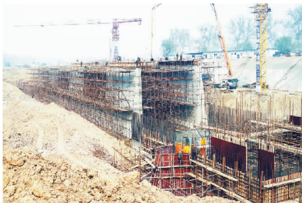
沙颍河周口至漯河航运开发工程周口船闸工程目前进展顺利。工程拟通过二级枢纽渠化周口市区至道遥段的55.9km航道,沿线配套建设两个港区和一个锚泊服务区。船闸建设工程包括船闸主体、引航道及导航、靠船建筑物、船闸管理区、补水泵站等。船闸是周口枢纽通航建筑物,船闸为IV级,可通行一顶二驳500t船队。
