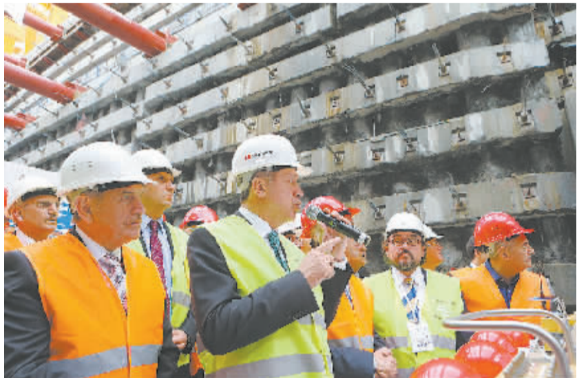
土耳其横跨欧亚海底公路隧道开工
