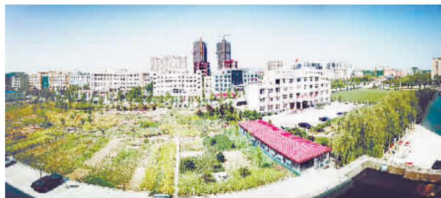
昨日,西华县行政新区草木葱郁,鸟语花香,街景优美;几处在建高档小区上空,塔吊正挥舞着塔臂作业。近两年来,西华县强力推进城区配套完善、形象提升和环境治理“三大工程”,努力让街道更净、环境更美、城市更靓,全力打造宜居县城。
