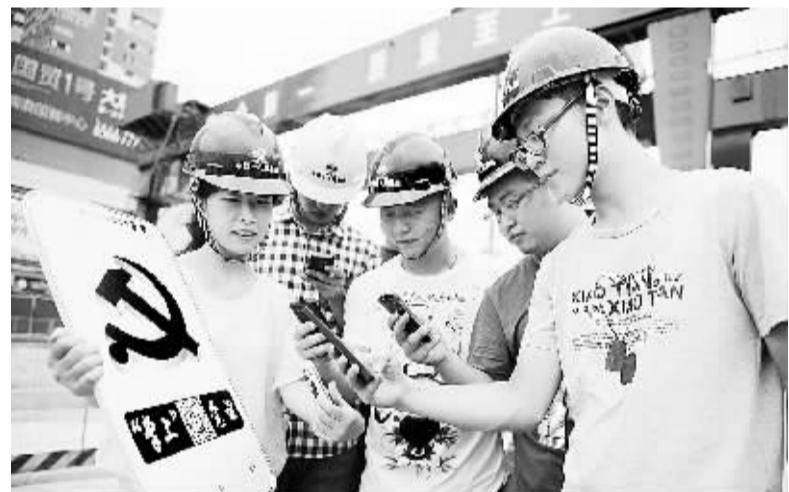
流动党员的随身“充电站” 7月17日,在合肥地铁二号线施工现场,流动党员建设者们在社区党务工作者的指导下扫描“掌上党课”二维码。当日,合肥铜陵路街道针对辖区流动党员较分散,流动性大,难以集中开展党课学习的实际情况,利用网络创新推出了手机“掌上党课”,为辖区流动党员量身定做学习课程。 新华社记者 杜宇 摄
