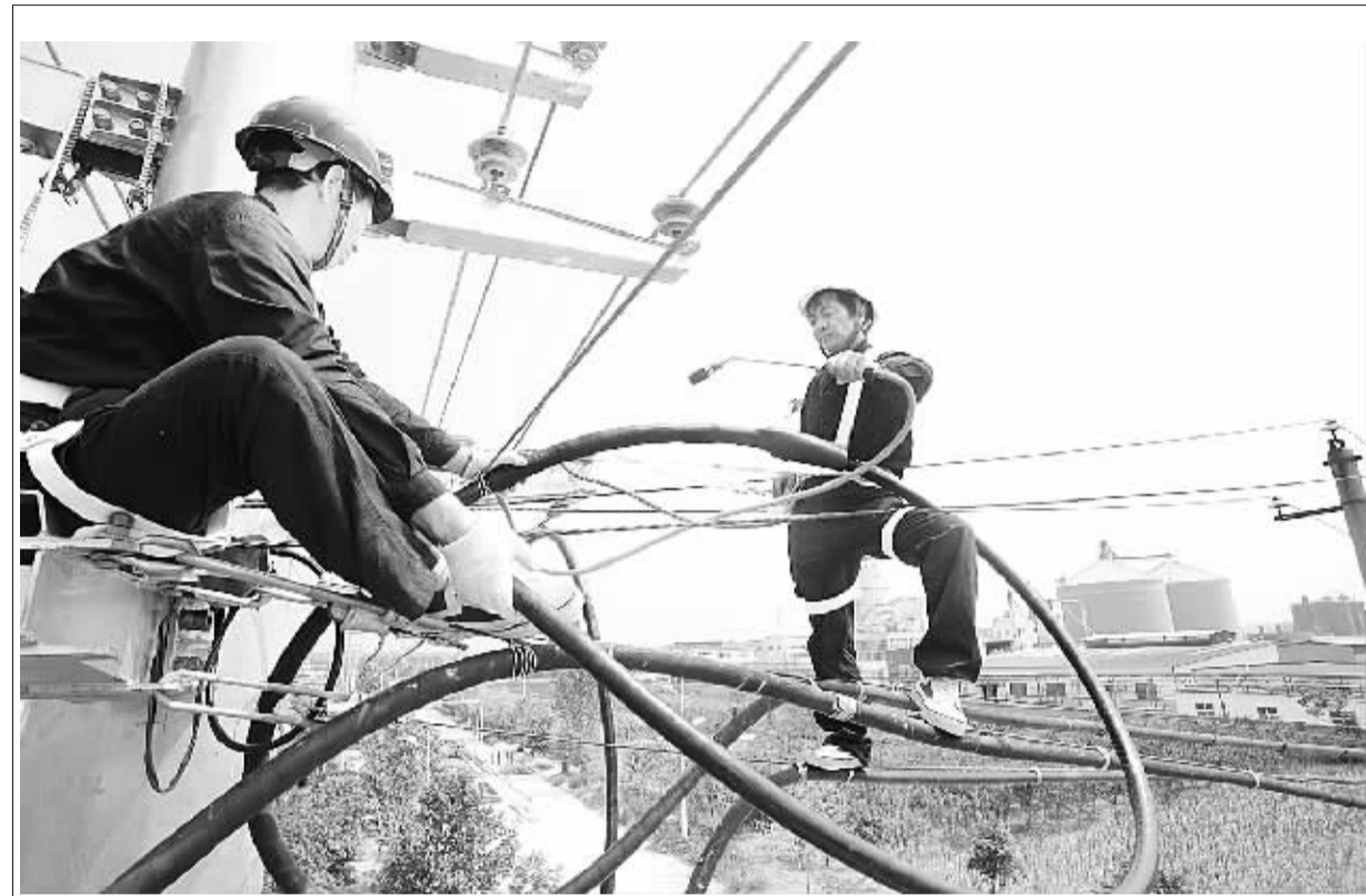
昨日,郸城县电业局职工冒着高温对 10KV 金丹线路进行改造,及时消除供电隐患,确保群众抗旱用电。(刘兴刚 郭庆灵 摄)
