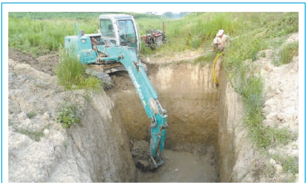
昨日,商水县舒庄乡一台挖土机正在河道里加深井深度。连日来,商水县旱情严重,河水干枯,部分机井水位下降无法使用。(乔连军摄)
