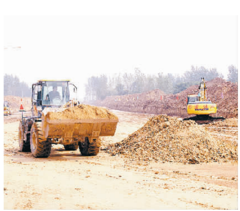
8月5日中午,项城市迎宾大道贯通工程工地上的工人,正冒着高温紧张施工。据悉,该工程是项城市城市建设中的“天字一号”工程,对于拉大城市建设主框架、带动其他重点项目建设具有十分重要的意义。该工程总投资3.5亿元,目前已全线施工。(张永久摄)
