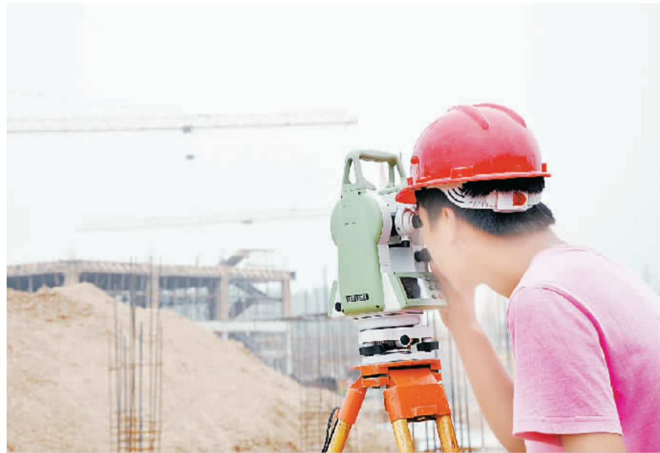
周口市益民小学和周口市第六幼儿园工程进展顺利,图为8月5日施工人员在现场作业。该项目位于周口高新技术产业开发区内,总投资1亿元。截至目前,图书综合楼一层框架结构已浇筑完成,二层模板基本制好,近日即可浇筑。其余建筑也正在按照施工计划推进。另据了解,作为2014年川汇区十件惠民实事之一,除新建“一校一园”外,另外3所中小学改扩建工作已接近尾声,其中,六一路小学项目和四中项目已经完成,七中改扩建正在紧张进行中。(理效明 摄)
