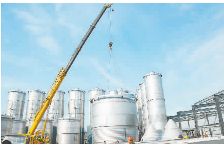
图为河南新华雪啤酒有限公司建设工地。
