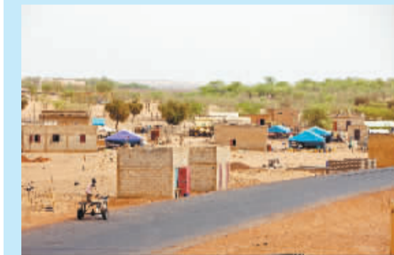
8月4日,在毛里塔尼亚马勒镇,当地人驾着驴车走在毛里塔尼亚希望三角洲公路上。位于毛里塔尼亚南部的下拉克纳省被称为“贫困三角洲”。2011年11月,这里启动由中国优惠贷款资助并修建的公路I标、II标项目,一条172公里的现代公路在广袤的沙漠中画出一条优美的曲线,结束了“贫困三角洲”不通公路的历史。
