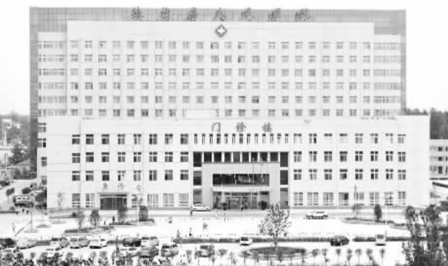
新落成的扶沟县人民医院病房大楼
