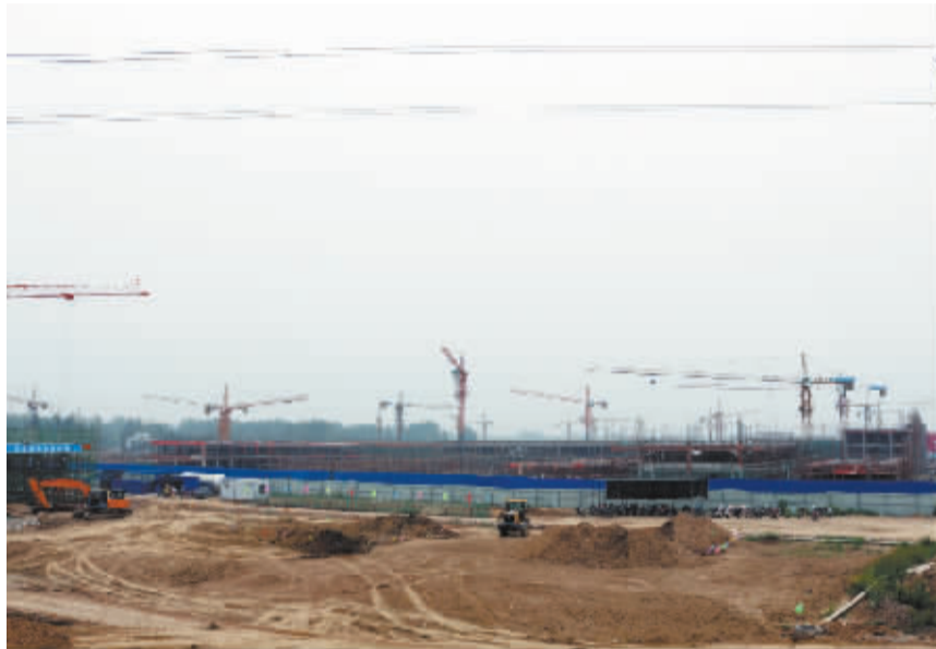
华耀商贸物流城建设现场。 效明 摄
