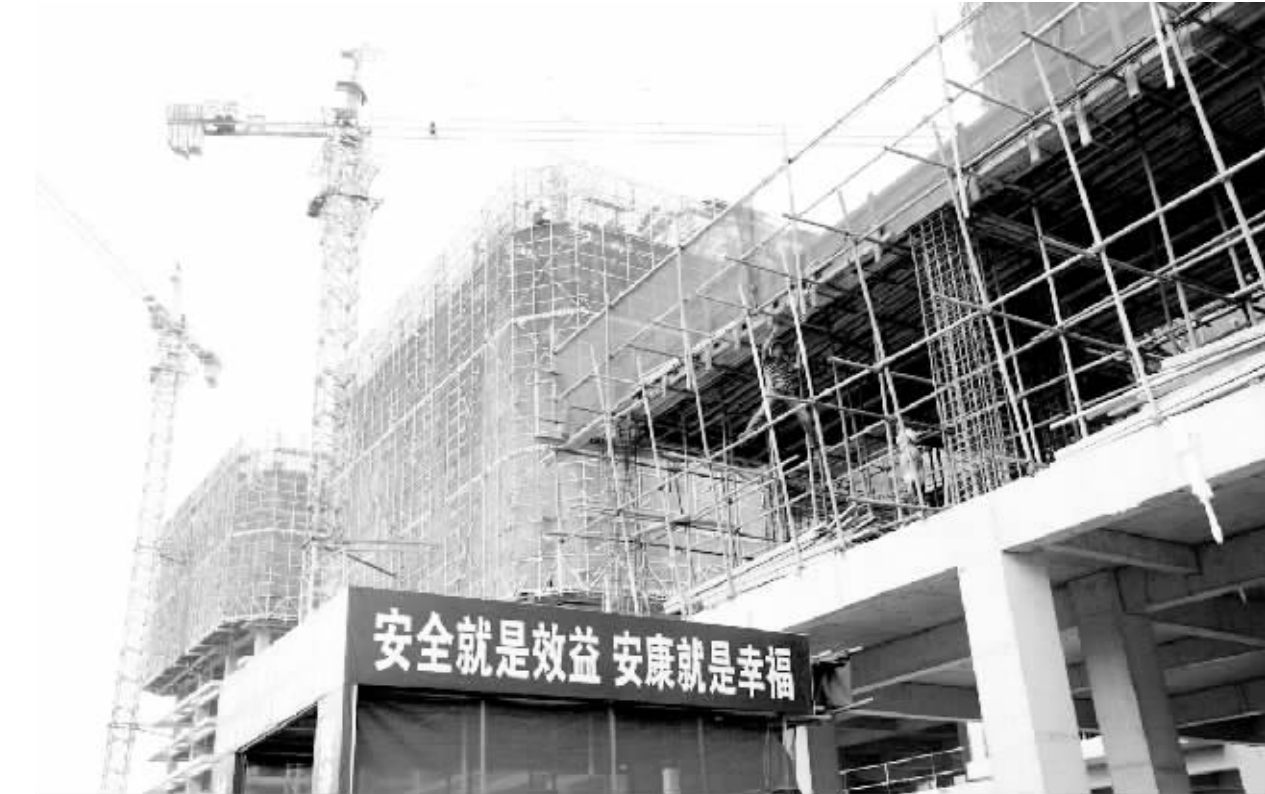
由周口报业昌建地产有限公司实施的“周口MOCO新世界”项目目前进展顺利。该项目建成后做居东新区核心区,将全面升级城市形象,缔造城市新地标,更以巨幕穹顶、空中花园等新颖设计,考虑未来使用功能的全面协调,实现人与建筑、建筑与城市、城市与环境的全面呼应和融合。(记者 沈湛 摄)
