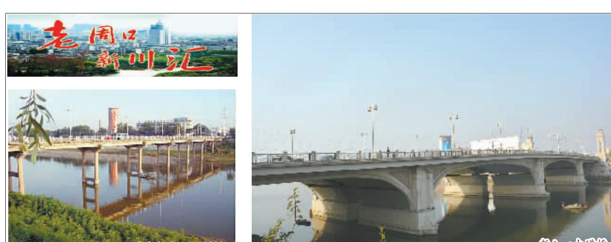
市八一路老桥（原胜利桥）修建于1968年11月，1969年12月竣工投入使用。桥宽9米，核载量为8吨。该桥是连接周口沙南、沙北的纽带，对周口市中心南北两区的发展有着举足轻
