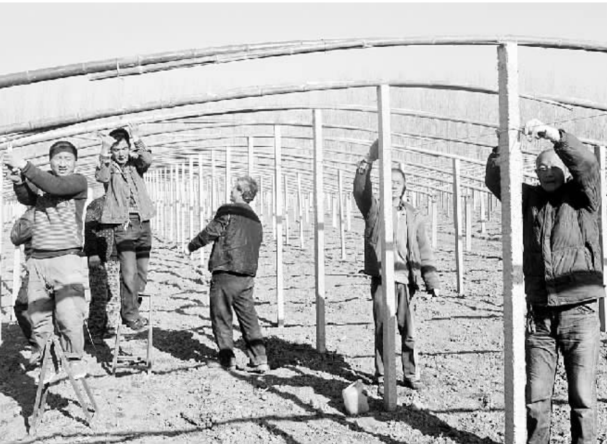
扶沟县整合资金 1490 万元对“周口市重点支持 20 个标准化蔬菜基地”进行新建和提升改造。图为崔桥镇伏果果业专业合作社社员正在建设的占地 340 亩的水泥立柱大棚。(谷志方 张普 摄)
