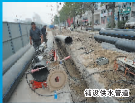
对老旧管网进行改造
