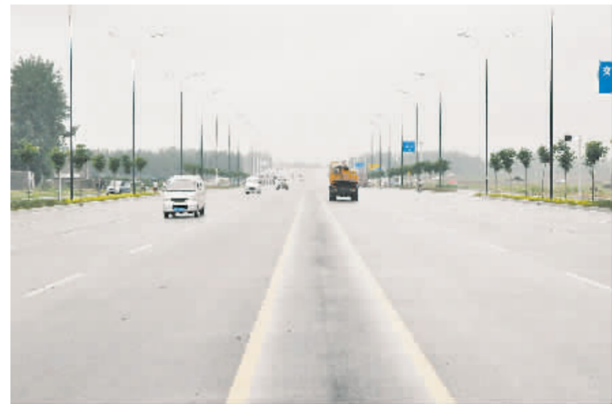
昨日,东外环路武盛大路段正式建成通车。(记者 王亚辉 摄)
