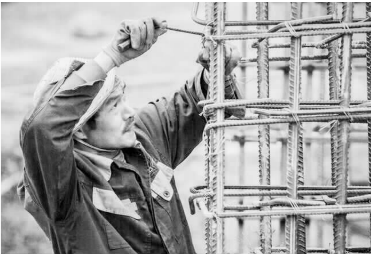
在华耀城建设工地上,刘顺风师傅正在忙着固定钢筋。
