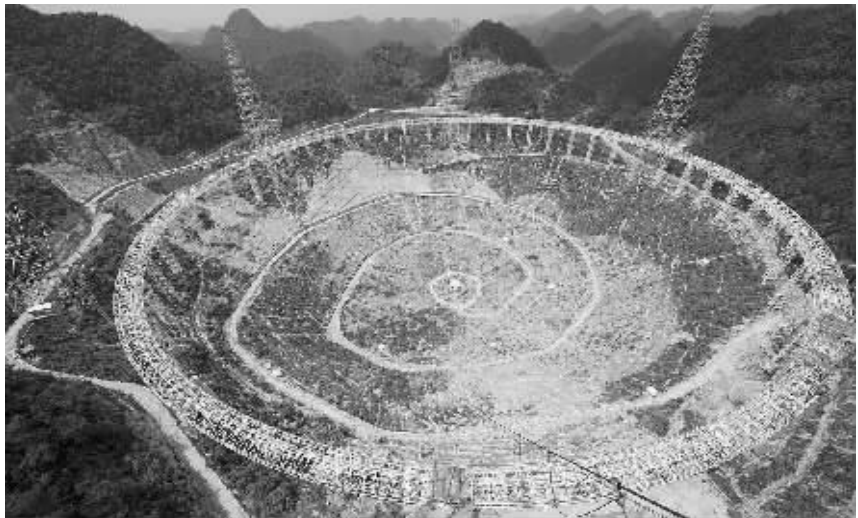
世界最大单口径射电望远镜将拼装首块面板 7月27日拍摄的正在建设中的500米口径球面射电望远镜。正在贵州黔南安装建设的500米口径球面射电望远镜（FAST），是目前世界上在建的口径最大、最具威力的单天线射电望远镜。目前，FAST已经完成索网制造与安装工程和支撑框架建设，即将进行反射面板拼装。这一超级望远镜有望在2016年9月建成，建成后将成为世界级射电天文研究中心。 新华社发
