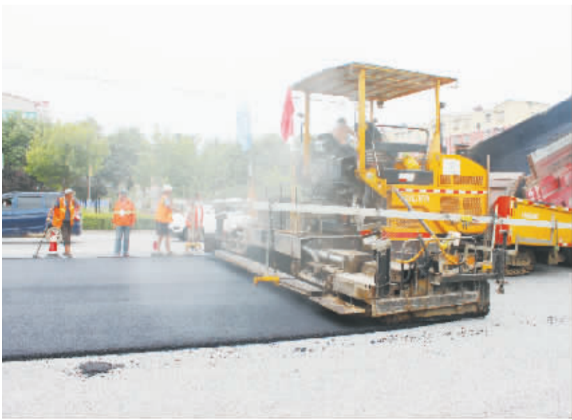
为迎接全国干线公路大检查,县公路局积极争取项目,对淮阳路、羲皇大道等路段进行了中修罩面,对沿线绿化带进行修剪,桥梁复漆,打造了畅洁绿美的公路环境。图为羲皇大道中修罩面施工现场。(魏兰荣 赵宁摄)
