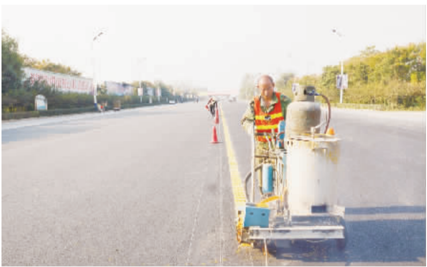
项城快速通道项城段工程建设已接近尾声,目前,主干道已实现通车。田维林 摄
