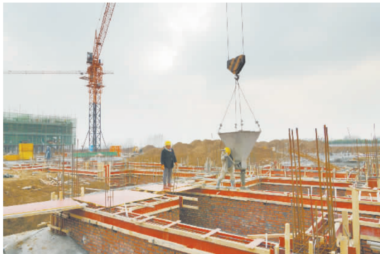
城南新区中学规划占地60余亩,总建筑面积1万多平方米,总投资约7000万元。自今年8月份开工以来,工程进展顺利,预计明年5月底竣工。蒋树保 王艳杰 摄
