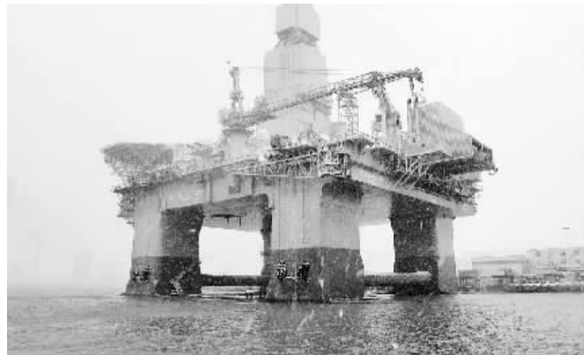
我国首座北极深水半潜式钻井平台“维京龙”在山东烟台完工。这是11月26日在中集来福士山东烟台建造基地拍摄的“维京龙”深水半潜式钻井平台。当日,由烟台中集来福士海洋工程有限公司为挪威一家公司建造的“维京龙”深水半潜式钻井平台在山东烟台完工并命名。这是我国建造的首座适合北海海域作业的深水半潜式钻井平台,拥有80%的自主知识产权,实现了“交钥匙”总包建造。新华社发
