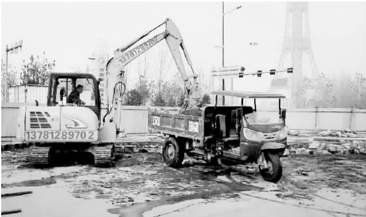
中心城区沙颍河周口大道桥南面的铁路道口附近到处是大大小小的坑槽,不少车辆通过此处时均减速慢行,严重影响了车辆通行,有关部门决定对此道口进行拆除。11月26日,记者来到施工现场,看到东半幅拆除工作正有条不紊地进行,很快路面就会整修一新。 记者 马四新 实习生 赵静 摄
