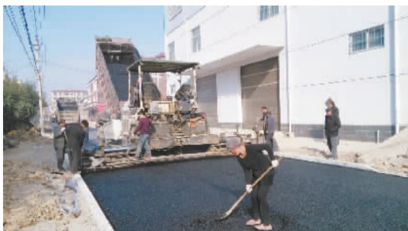
硬化小街小巷,进一步改善群众出行条件,是川汇区2015年十件民生实事之一。区域城建办和各相关办事处通力合作,狠抓落实,目前,11条小街小巷的硬化升级改造已全部完工。图为正在铺油的金海路办事处新村社区道路。 理效明 刘巍 摄
