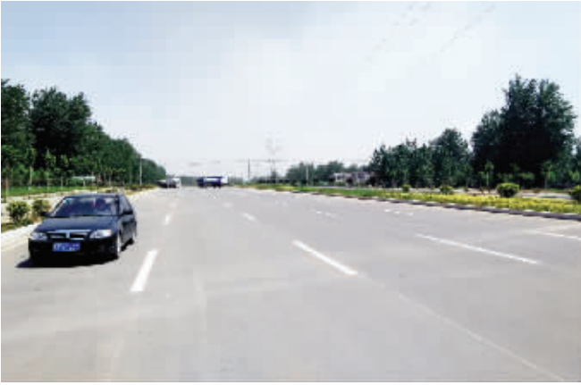
港区新建道路平整宽阔
