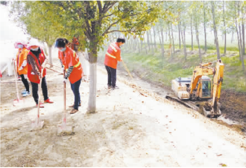
为做好干线公路养护会战工作,县公路局不等不靠开展公路绿化美化工程,着力打造公路标准化路段。图为养护工人在对淮周路进行标准化路肩边坡整修。 龚路 摄
